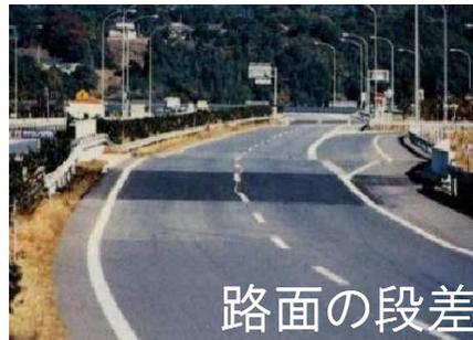
周辺地盤に与える影響を最小限に抑え且つ横断構造物の不同沈下による段差の解消を図るため、横断構造物を削減し、盛土を下げる道路構造を計画。
